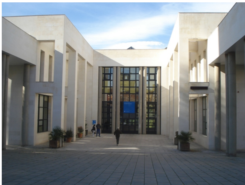
Fachada de la biblioteca
