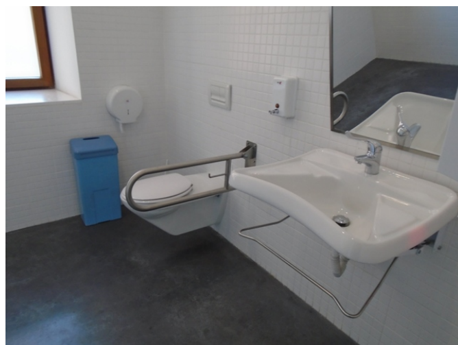
Aseo común adaptado
