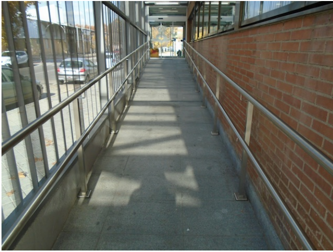
Rampa de acceso a la biblioteca
