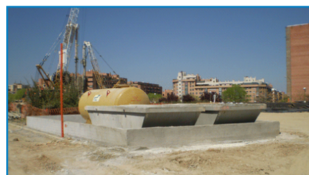
Gráfico 47. Detalle de zona habilitada para limpieza de canaletas de cubas de hormigón
