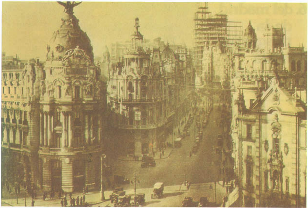
La Gran Vía en el comienzo de su construcción
