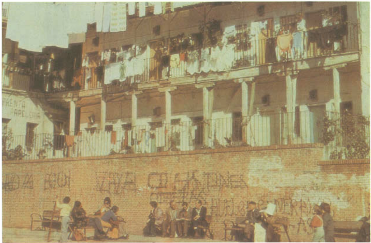
La Corrala. Edificación típica madrileña que en la actualidad se quiere remodelar y adecuar a nuevas necesidades de habitabilidad.
