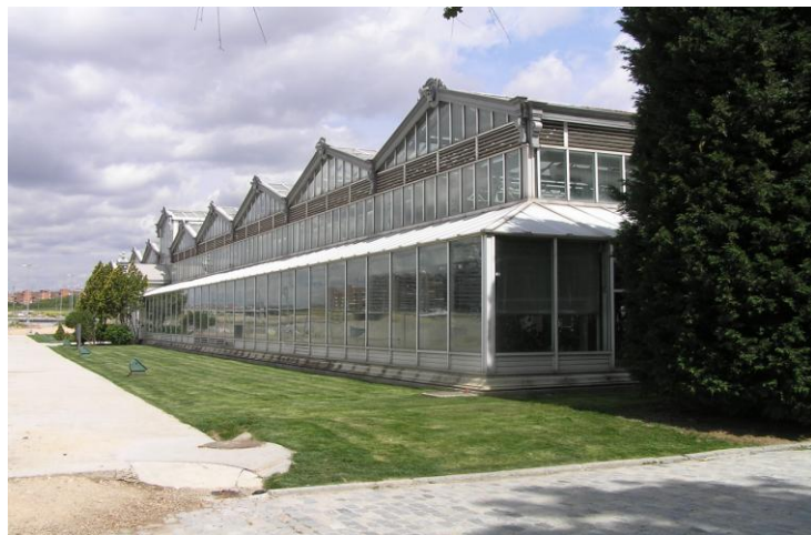
Fachada principal del invernadero de Arganzuela
