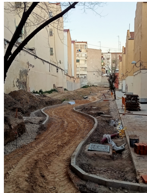
Colonia Quinta del Pilar. Ejecución de obra
