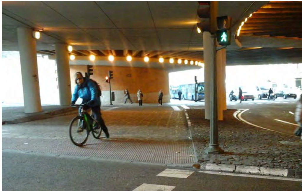
Paso Inferior Bailen
