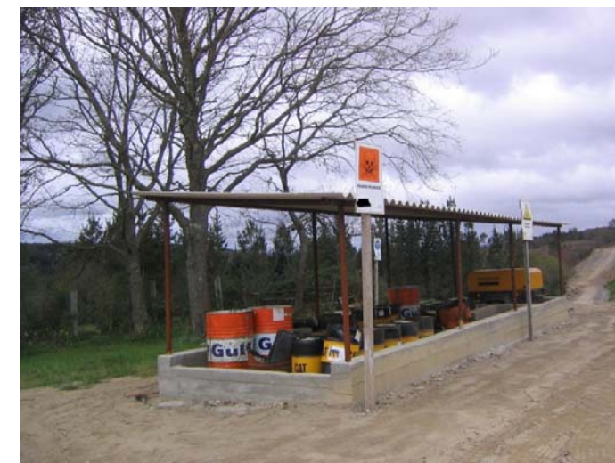
Ilustración 8-1. Ejemplo de zona de almacenaje de residuos peligrosos.
