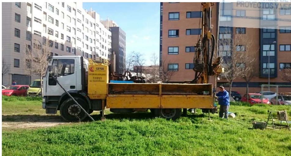
Figura Nº 4.- Emplazamiento del sondeo a rotación S-01
