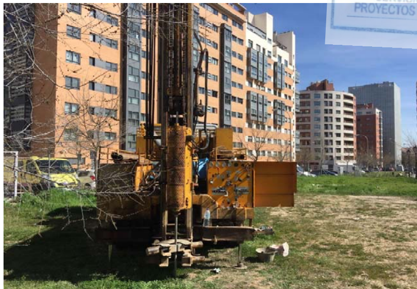
Figura Nº 6.- Emplazamiento del ensayo de penetración dinámica P-01
