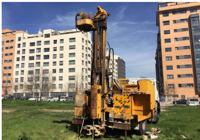
Figura Nº 7.- Emplazamiento del ensayo de penetración dinámica P-02
