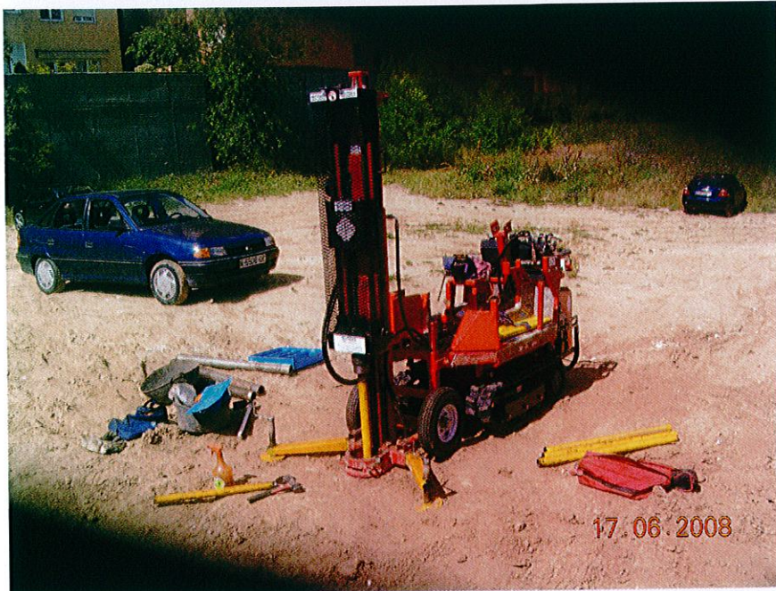
VISTA GENERAL DEL SONDEO S1.
