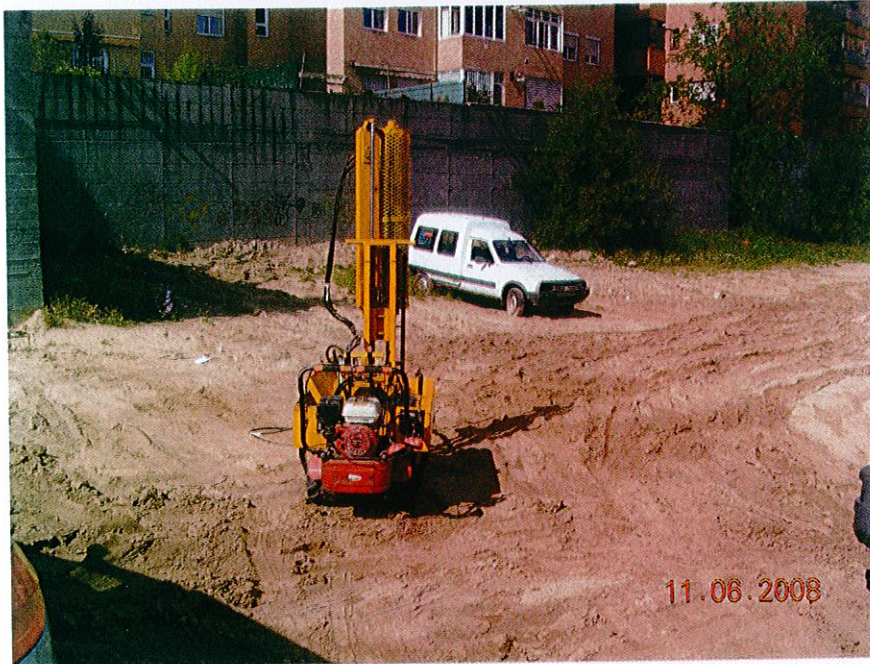
ENSAYO DE PENETRACION P1
