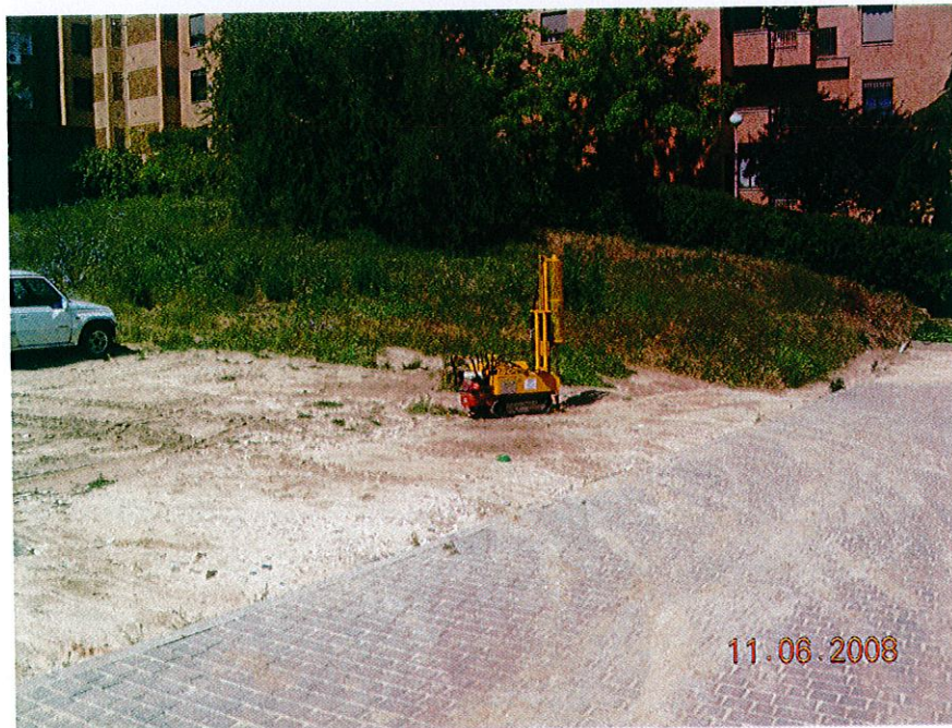
ENSAYO DE PENETRACION P2
