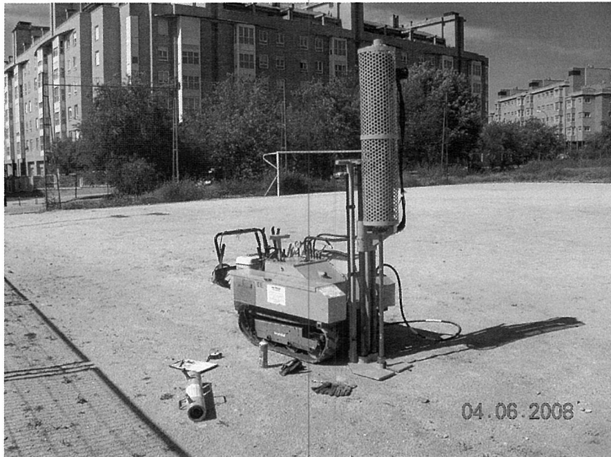
ENSAYO DE PENETRACION P1
