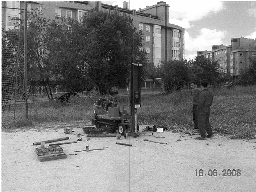
VISTA GENERAL DEL SONDEO S1.
