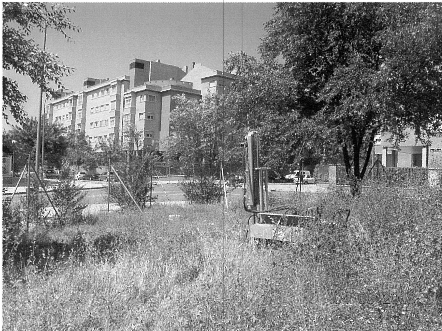
ENSAYO DE PENETRACION P2
