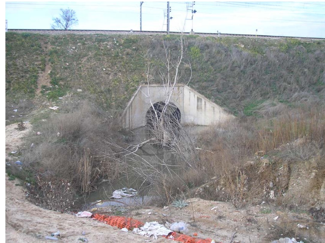
35.- Cruce del arroyo del Fresno bajo FFCC
