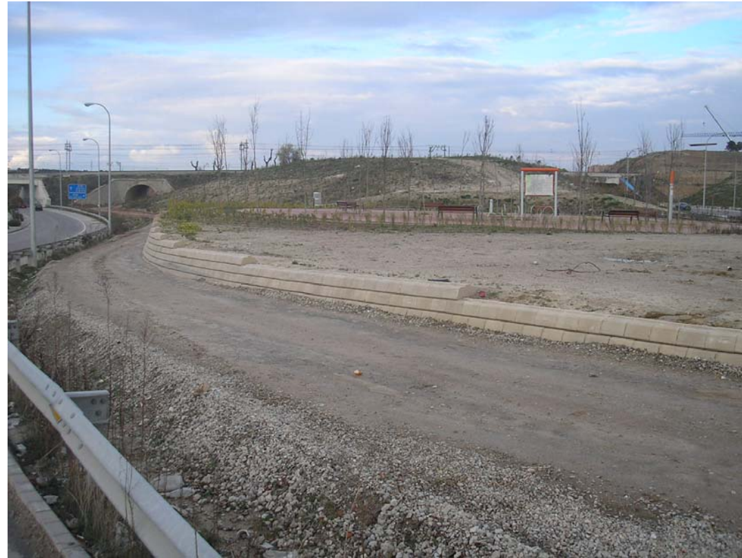
29.- Paso bajo FFCC y tramo paralelo al Ventisquero de la Condesa
