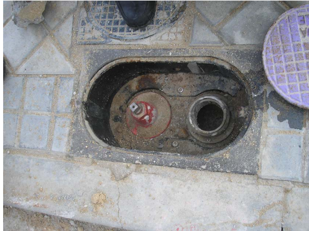
9.- Dársena nº6. Detalle de toma.
