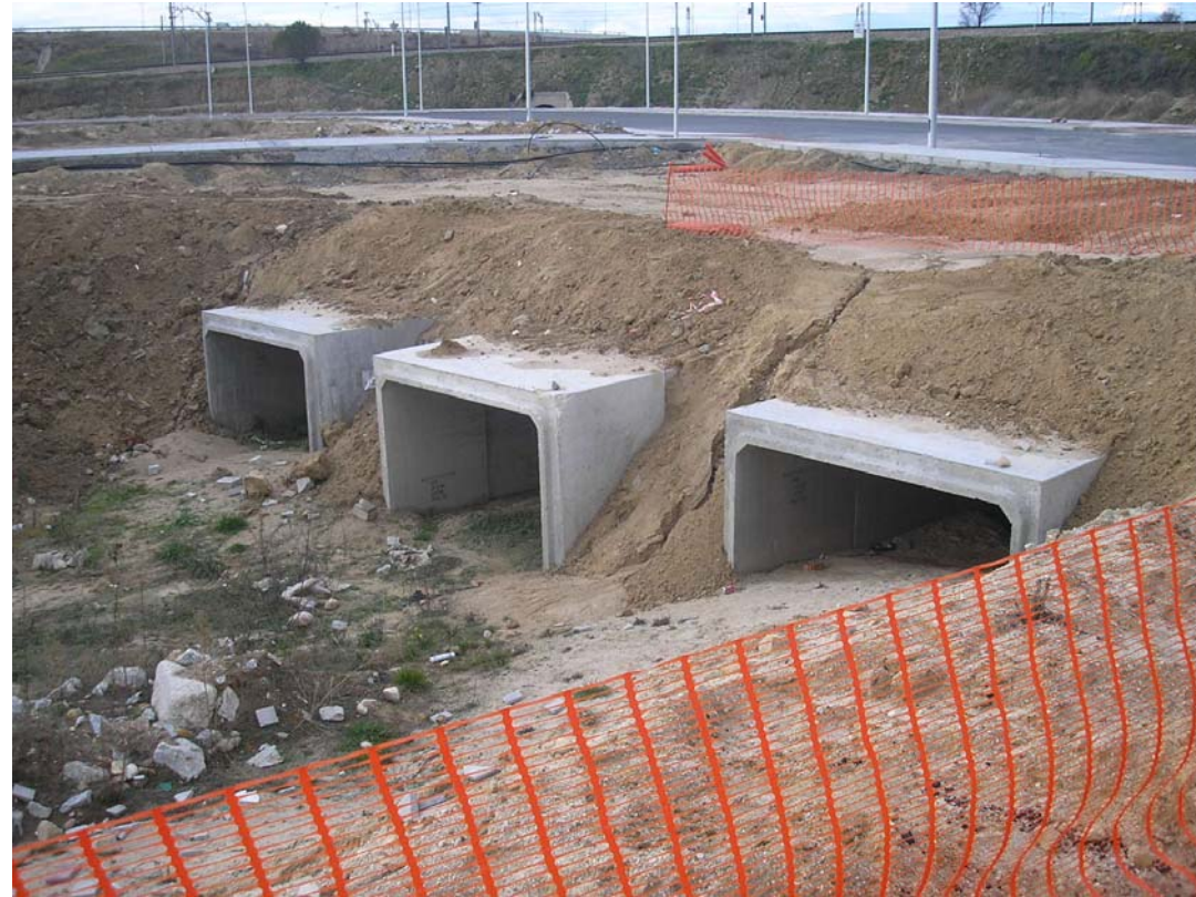
37.- Caños en PAU Arroyofresno para arroyo
