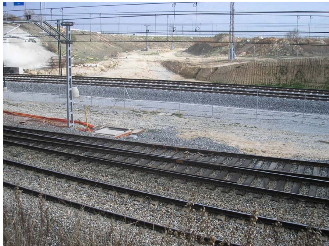
18.- Cruce bajo enlace carretera de Colmenar
