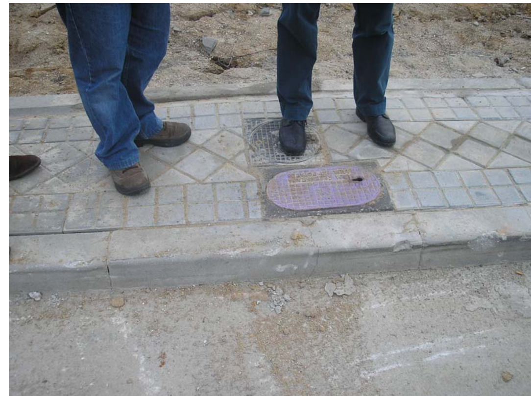
8.- Dársena nº6. Detalle de toma.
