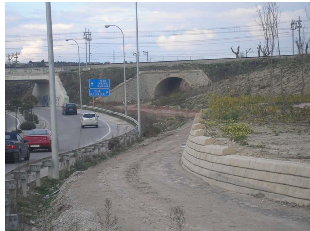
28.- Paso bajo FFCC y tramo paralelo al Ventisquero de la Condesa
