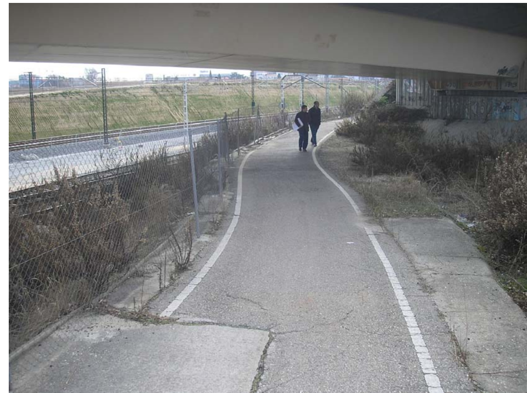
20.- Cruce bajo enlace carretera de Colmenar
