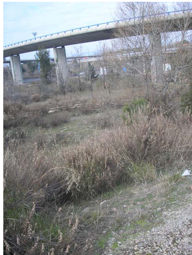
22.- Cruce bajo enlace carretera de Colmenar
