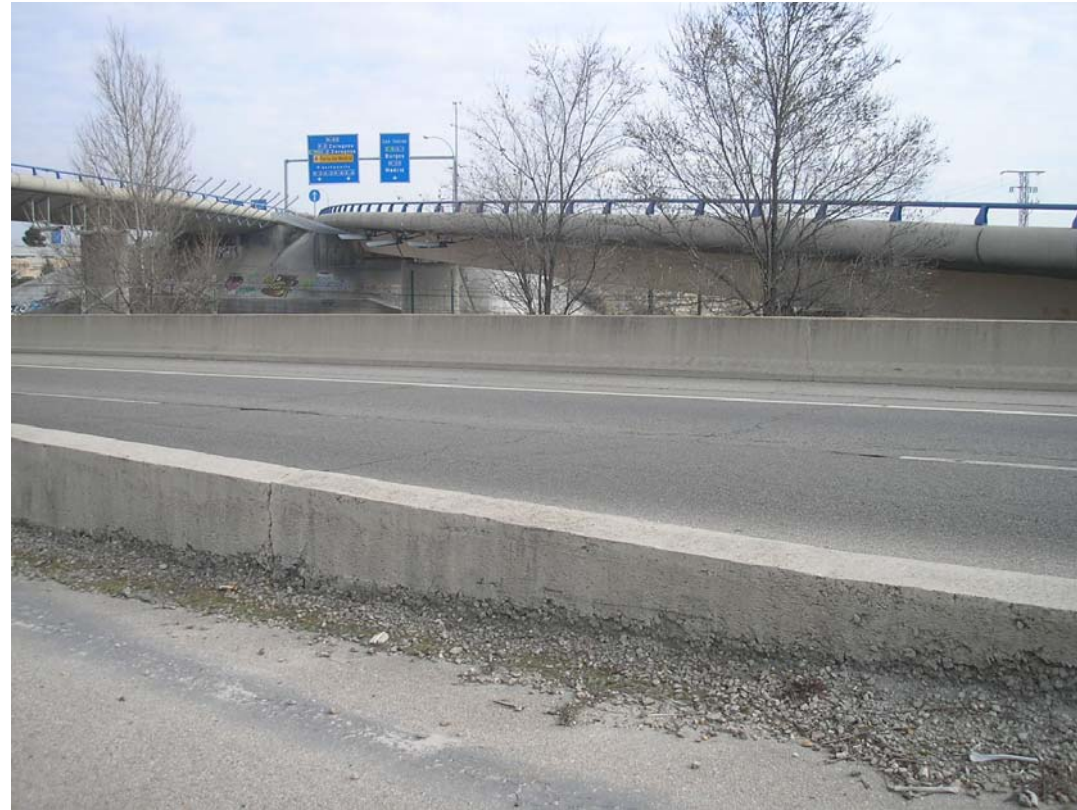
21.- Cruce bajo enlace carretera de Colmenar
