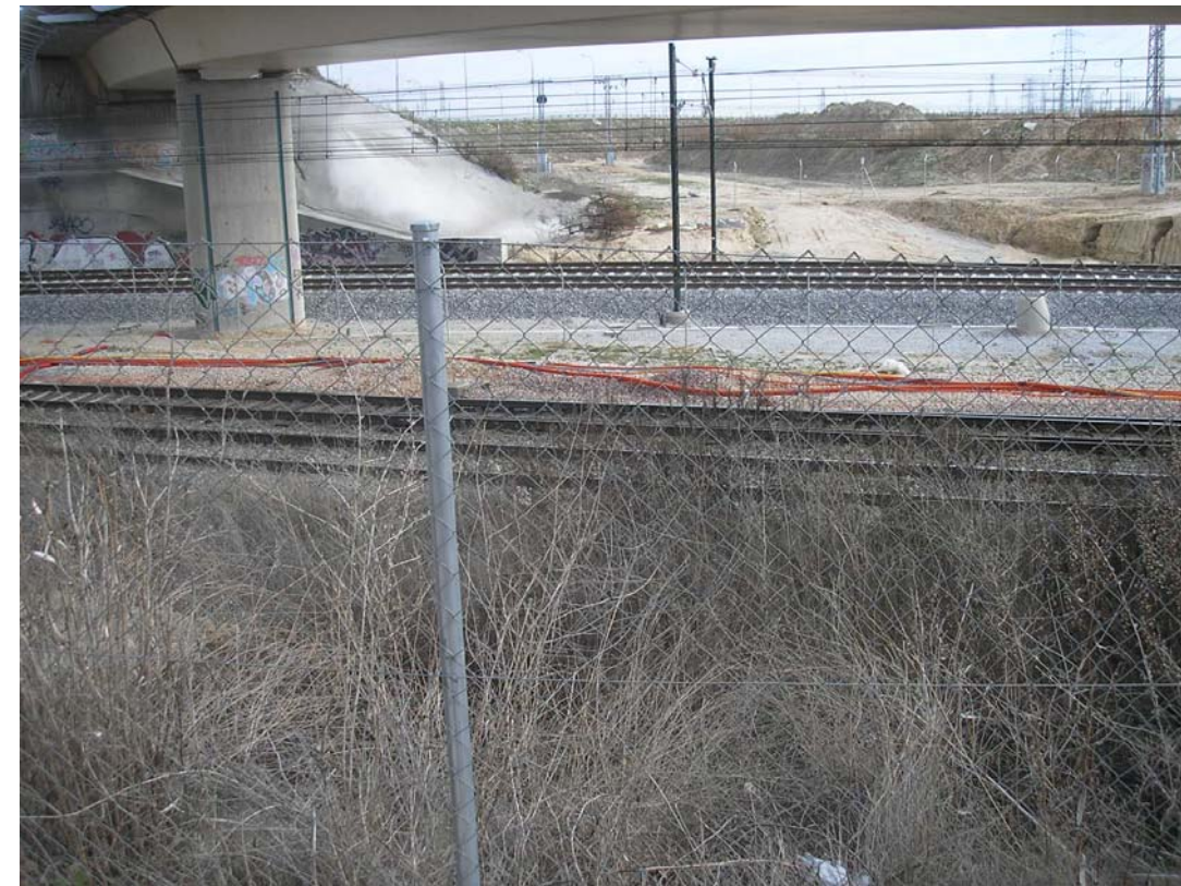
19.- Cruce bajo enlace carretera de Colmenar
