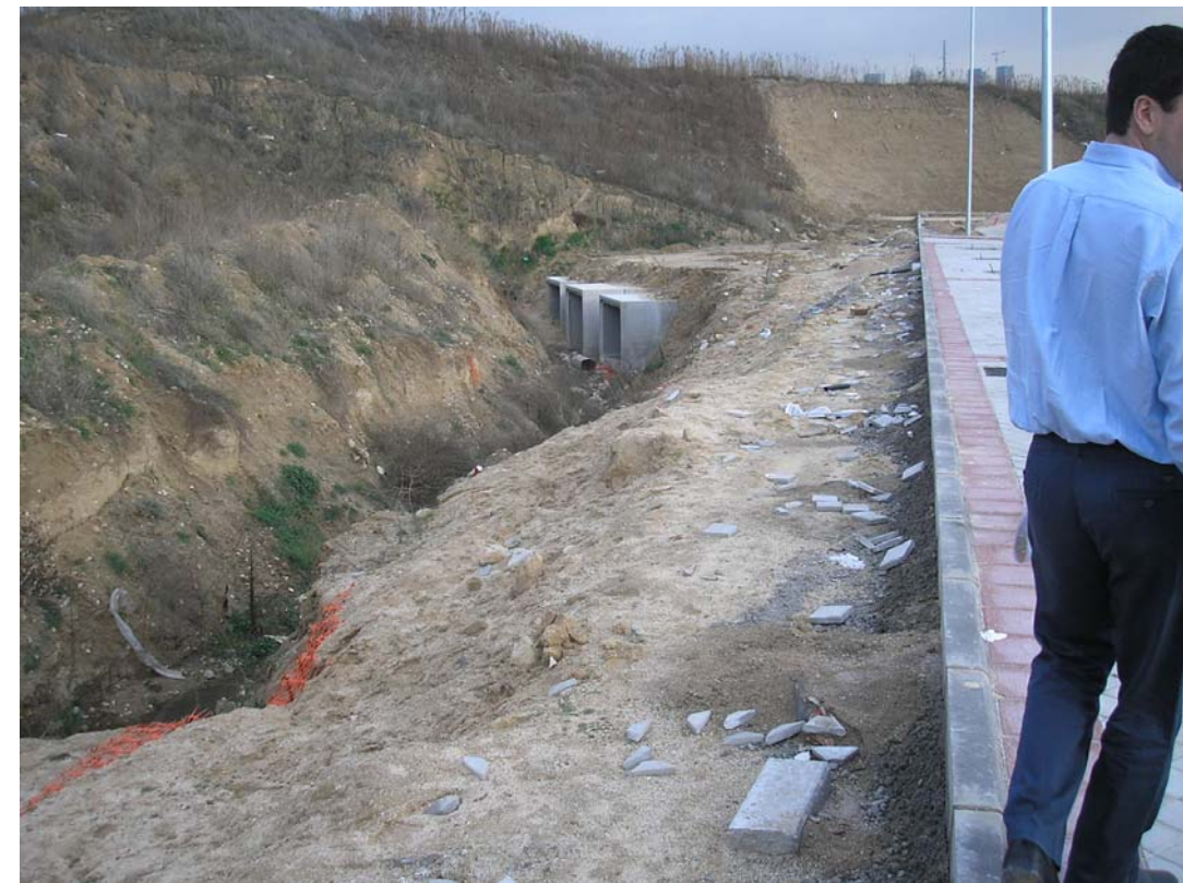
36.- Caños en PAU Arroyofresno para arroyo
