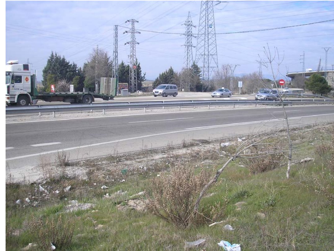
23.- Cruce bajo enlace carretera de Colmenar
