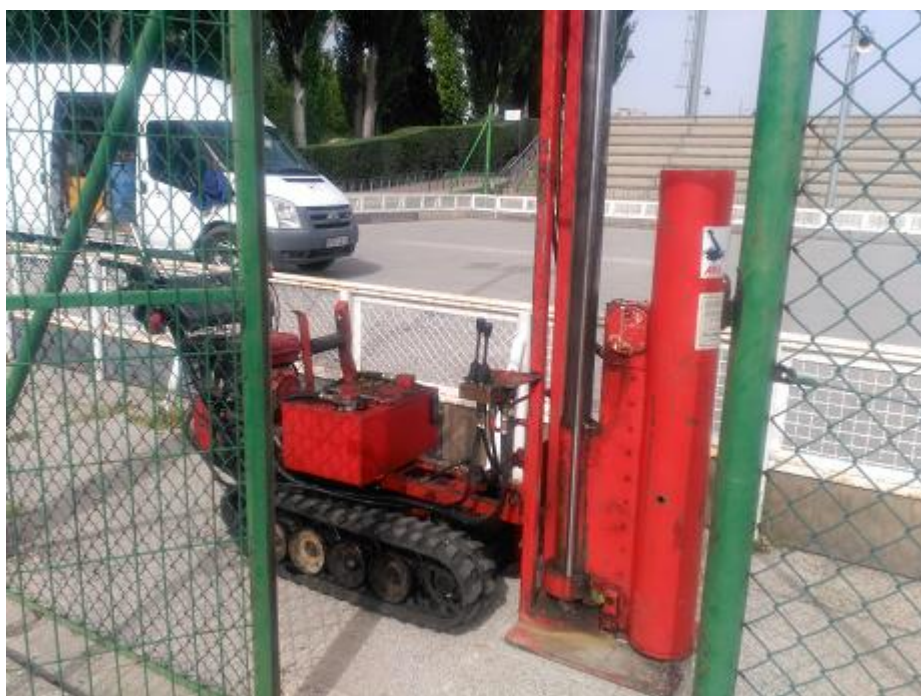
Punto de ensayo de penetración dinámica P1
