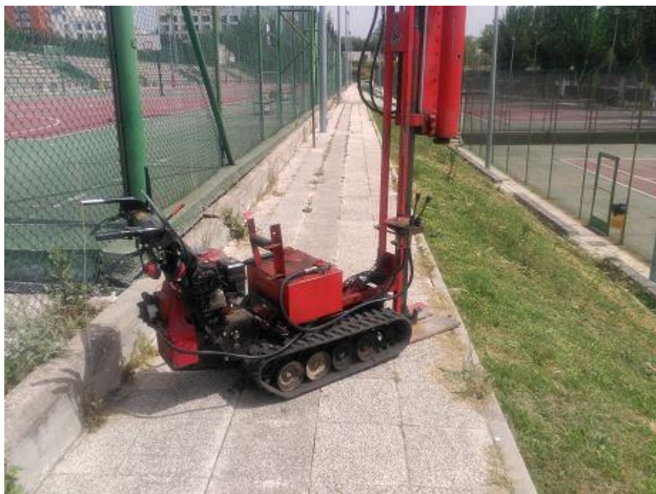
Punto de ensayo de penetración dinámica P3
