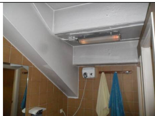
Iluminación Vestuarios Personal
