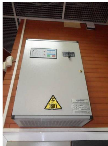
Batería condensadores
