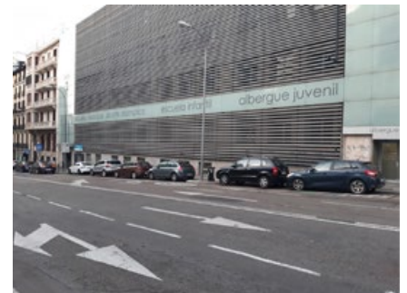
↑ Sobredimensión de calzada y falta de elementos naturales
