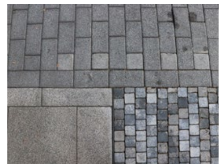
↑ Detalle de la disposición de distintos pavimentos discontinuos drenantes por junta, Madrid
