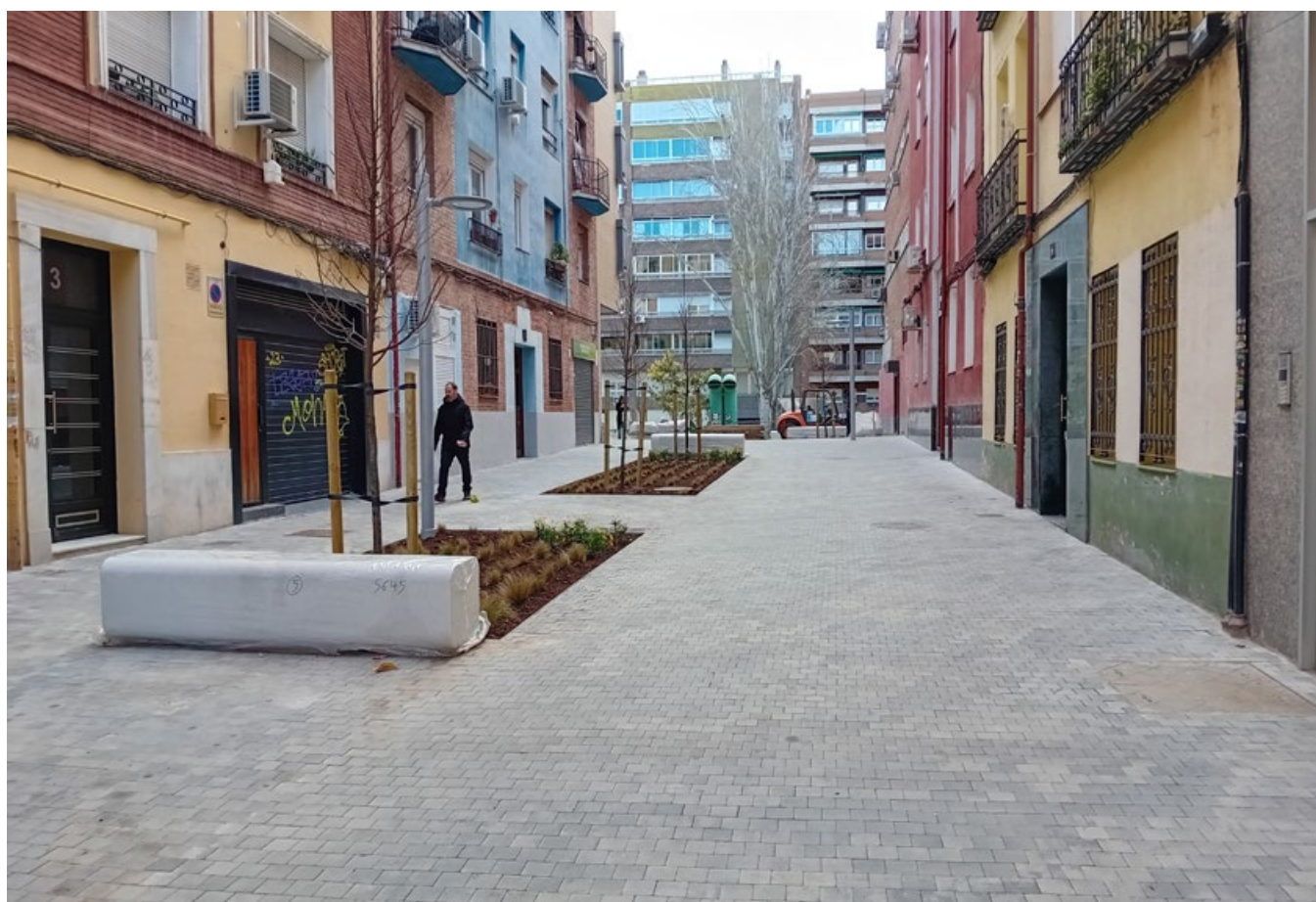
1 Galería Vallehermoso, antes y después de la intervención
