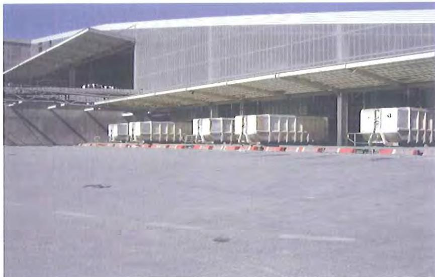
**8.- Planta de tratamiento de lixiviados.** Su capacidad de tratamiento actual es de 50 m<sup>3</sup> diarios, ampliable hasta 200 m<sup>3</sup>/día en función de las necesidades (número de celdas del vertedero). El tratamiento se realiza mediante un proceso de ósmosis inversa en tres etapas.
