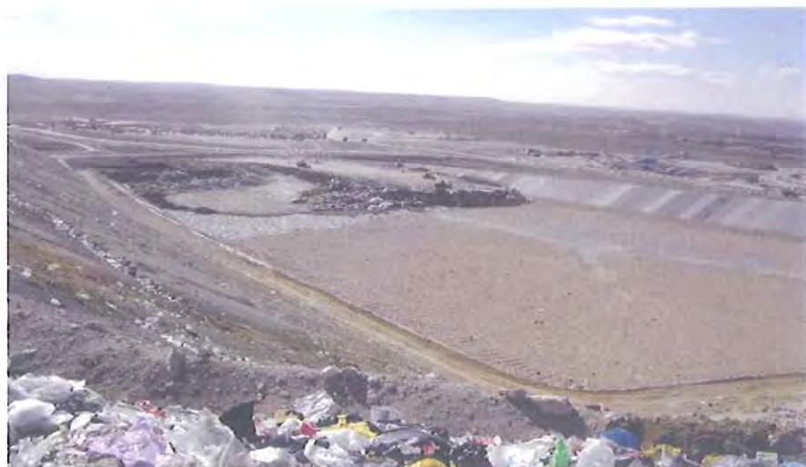
**10.- Desgasificación del vertedero controlado de cola.** La extracción del biogás del vertedero se lleva a cabo mediante pozos de captación de biogás, estaciones de regulación y medida (ERM) y una central de extracción secundaria para el envío del biogás a la central de valorización energética. La instalación de los pozos y la red de conducción de biogás se completa a medida que se colmatan las celdas del vertedero en explotación.
