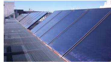
El volumen de agua producida no se cuantifica, si bien, tenemos un valor de referencia obtenido a través de la Auditoría Energética realizada en el **Palacio de Cibeles** en diciembre de 2012 que indica que el calor aportado por la instalación solar térmica es de **19,087 MWh (0,019 MWh/persona trabajadora en 2021)**. El número promedio de personas trabajadoras en este periodo ha sido de 984.
