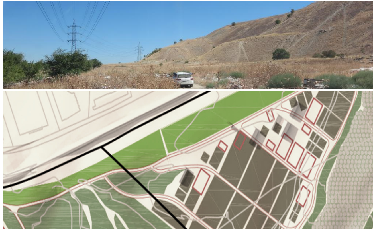
Fig.32: Montañas minerales de acopios de material yesífero y planta de distribución del "Vivero de Suelos"
