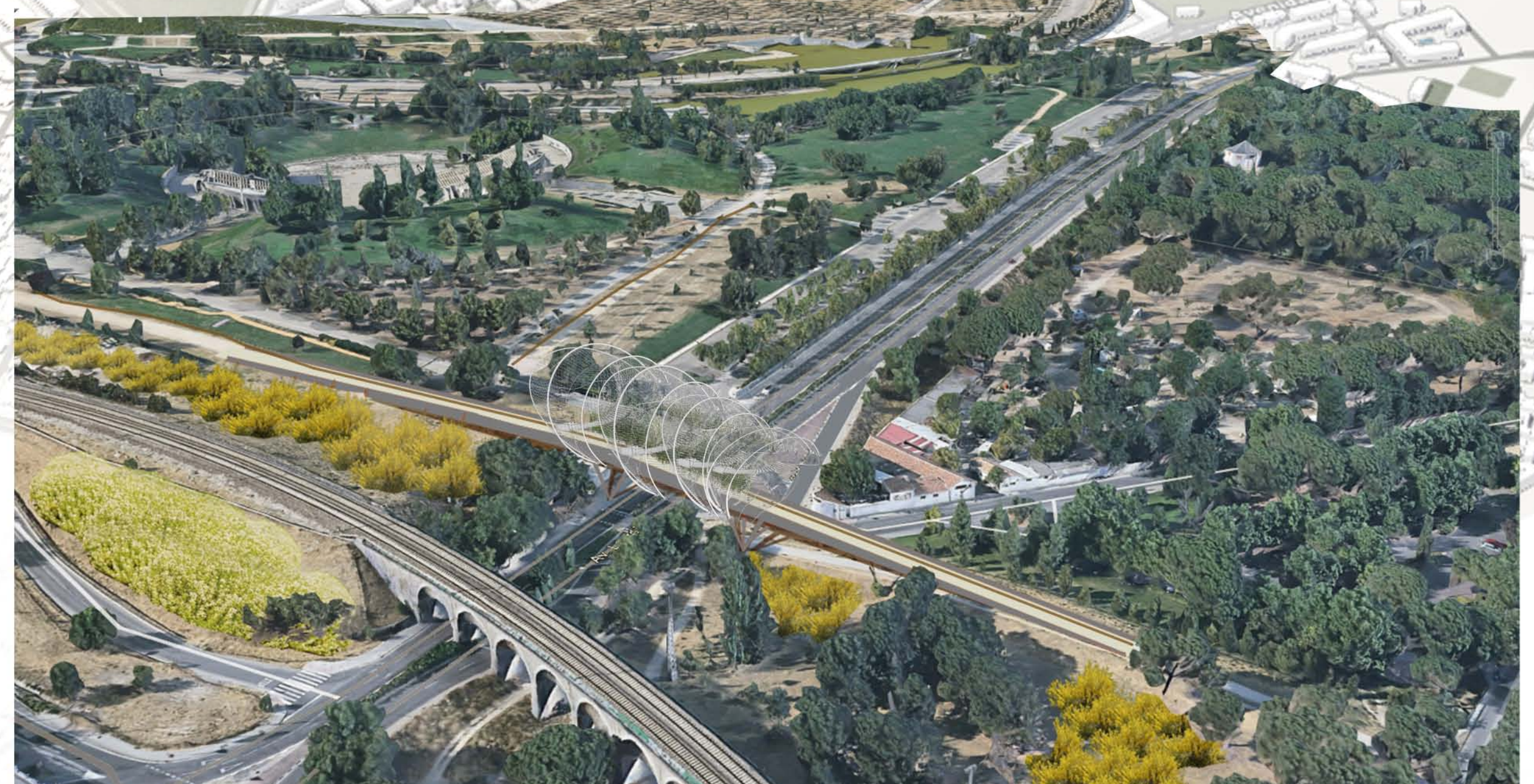
NUEVA PASARELA FORESTAL ENTRE EL CAPRICHIO Y EL PARQUE JUAN CARLOS I
